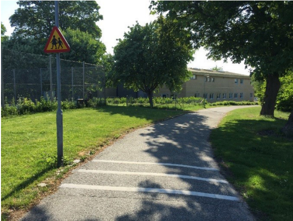
Malmö - Krossverksgatan. Inför korsningen med grindar är bullerremсор utplacerade i tre omgångar.
