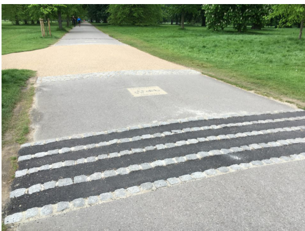
Avvikande markbeläggning likt rumble strips tillsammans med uppmärksamhetshöjande målning på marken i London, England
