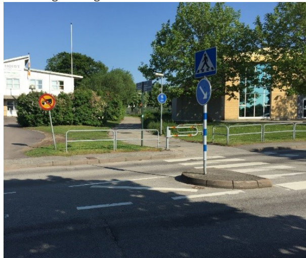
Grindar Malmö- Krossverksgatan, med extra staket utplacerade på sidorna
